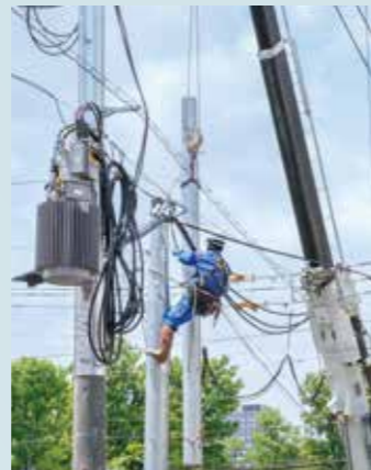
電柱設置工事
