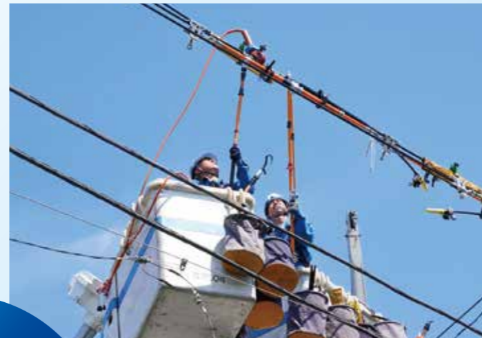
安全を考慮した新工法の導入(間接活線工事)
