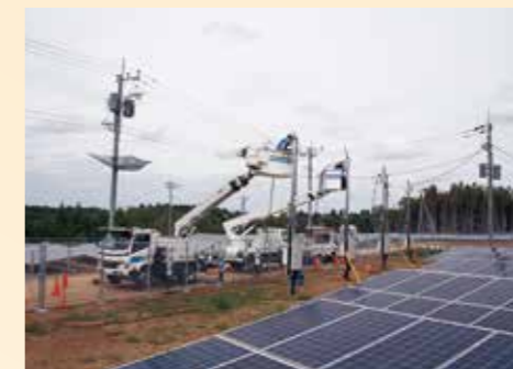
太陽光発電との接続工事
