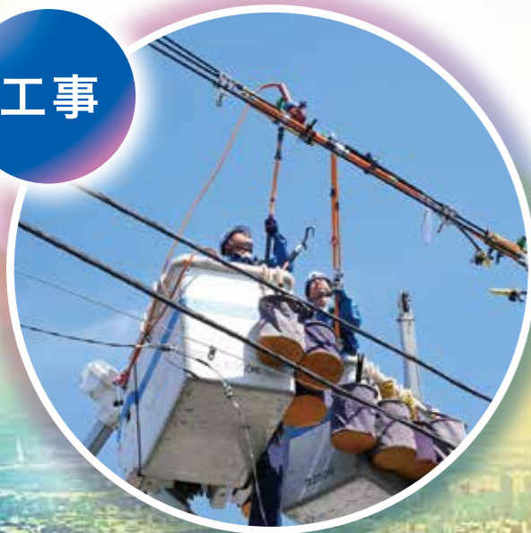
間接活線工事
