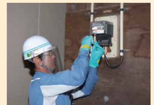
スマートメーター設置工事
