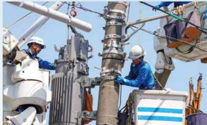
変圧器設置工事
