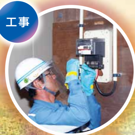
電気メーター取替え工事
