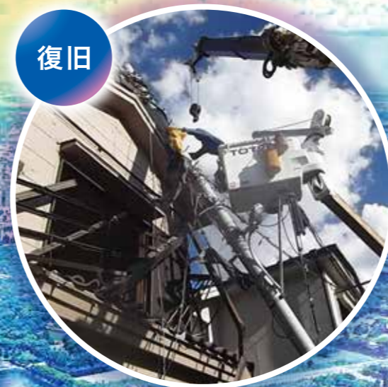
災害復旧工事
