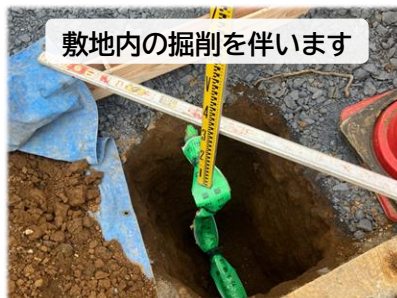
ガス管引き込み工事中
