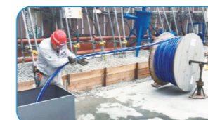
タワークレーン電源工事
