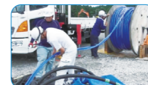
太陽光発電所工事
