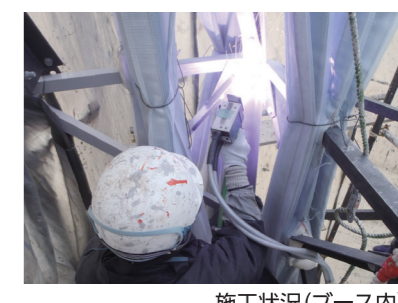
施工状況(ブース内)
