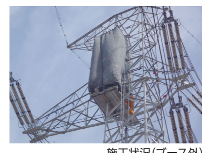
施工状況(ブース外)
