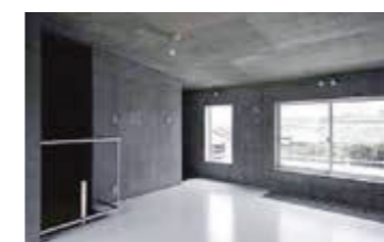
内装の床断熱に使用
