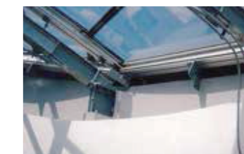
天窗周囲コンクリートの断熱
