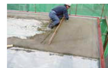
屋上の防水下地に使用(鉄骨造)
