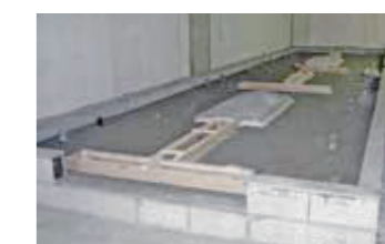
商業施設の厨房床の軽量化
