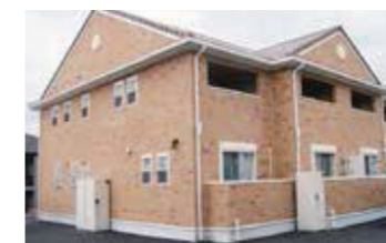
基礎部分の壁の断熱
