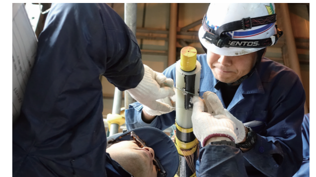
ケーブル外導処理
