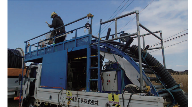
ケーブル引入作業
