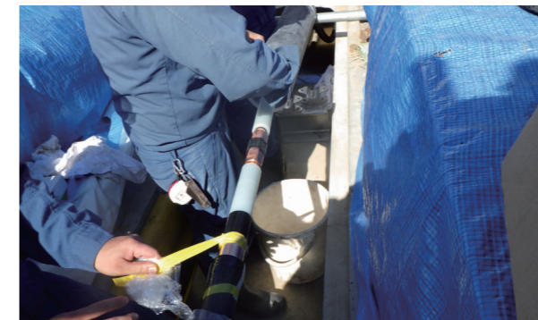
接続作業(ジョイント部)
