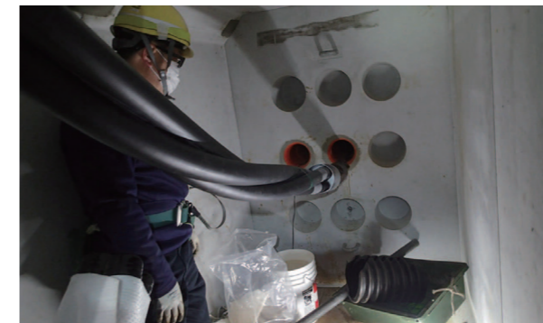
ケーブル引入作業(マンホール内)
