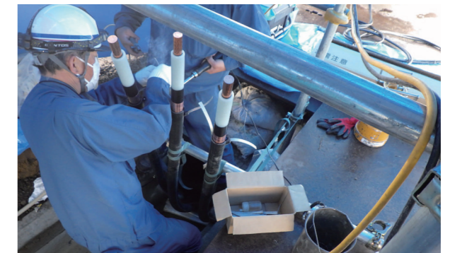
接続作業(終端部)
