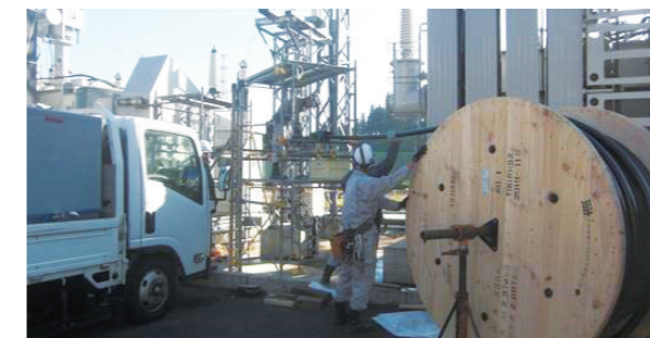
CVケーブル引替工事
