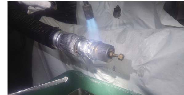
鉛工による端末処理
