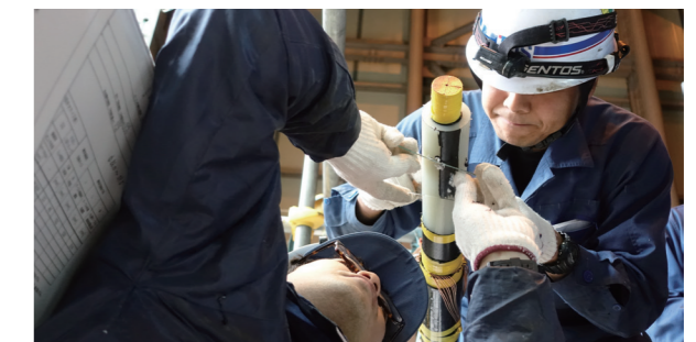
CVケーブル引替工事
