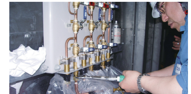
バルブパネルの補修
