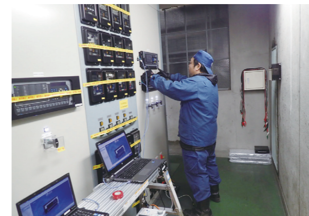
保護リレー取替工事
