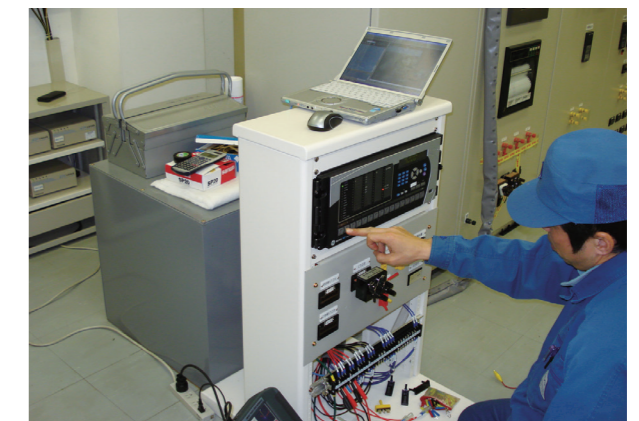
仮設保護制御盤設置工事
