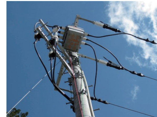
25年を経過した高圧受電設備の更新
