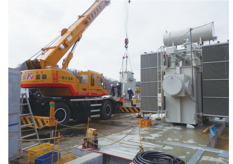
特高変電所新設工事
