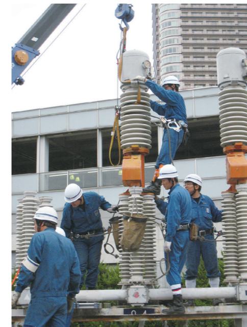
特高変電所更新工事
