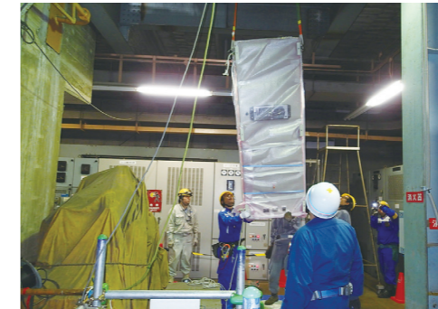
発電機盤他更新工事
