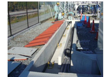
ケーブル敷設工事
