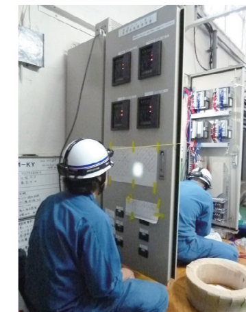
キュービクル更新工事
