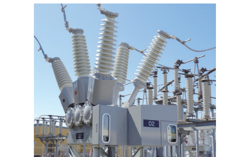
72/84kV タンク形ガス遮断器
