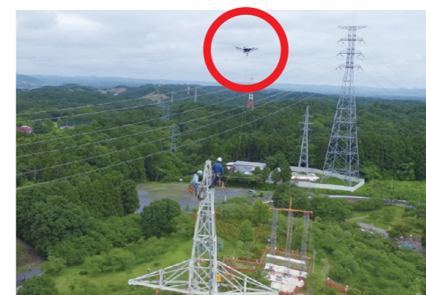
ロープ延線状況
