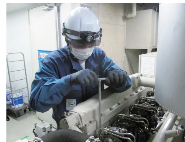
燃料噴射ノズル点検①
