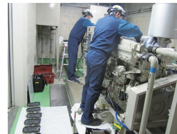
燃料噴射ノズル点検②
