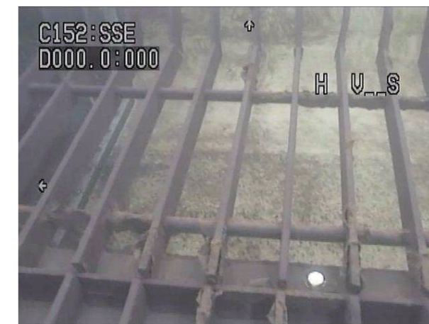
水中点検ロボット 撮影画像(水中カメラ)
