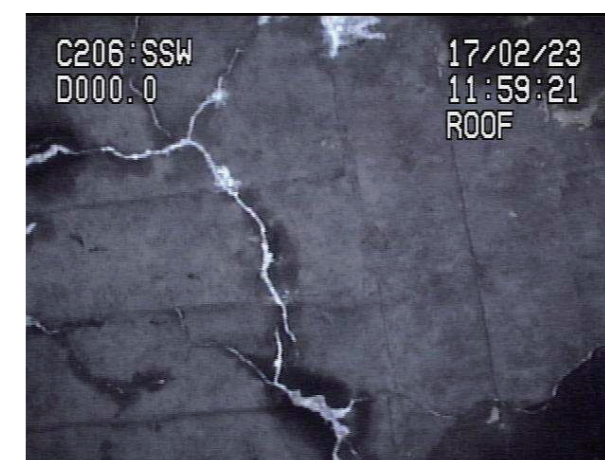
水中点検ロボット 撮影画像(気中部観察カメラ)
