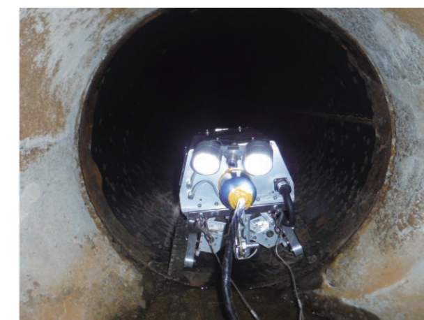
小口径管内部点検状況
