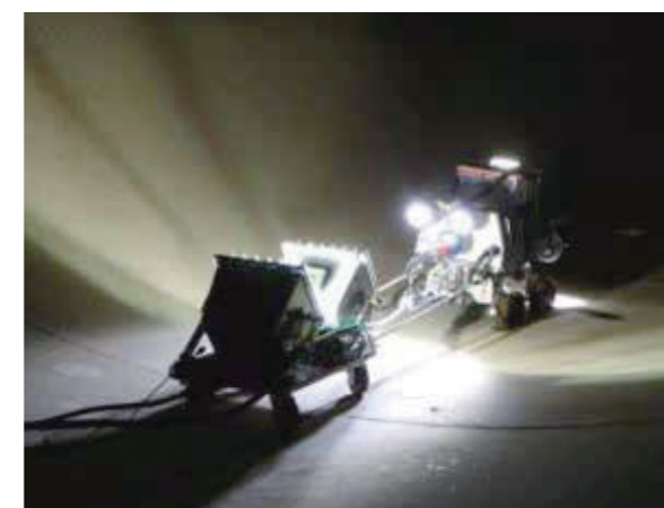
大口径管内部点検状況
