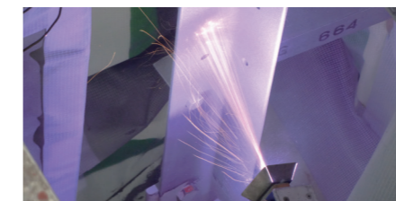
Arts(防錆溶射)工法
