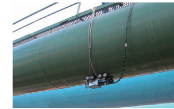
水管橋板厚測定
