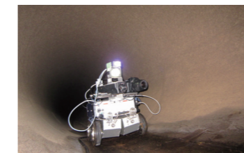
水圧管内部点検
