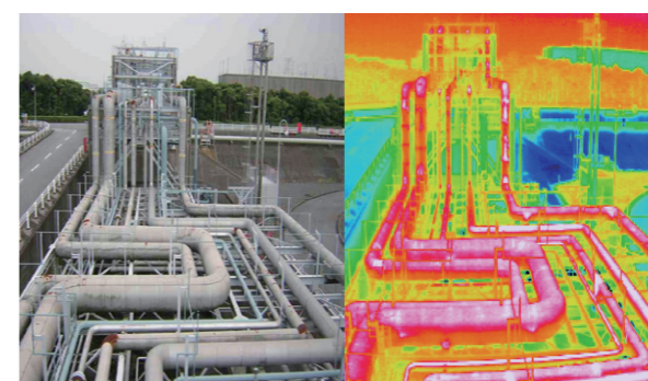
配管赤外線サーモグラフィ
