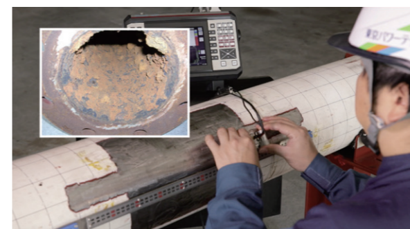
超音波配管減肉検査
