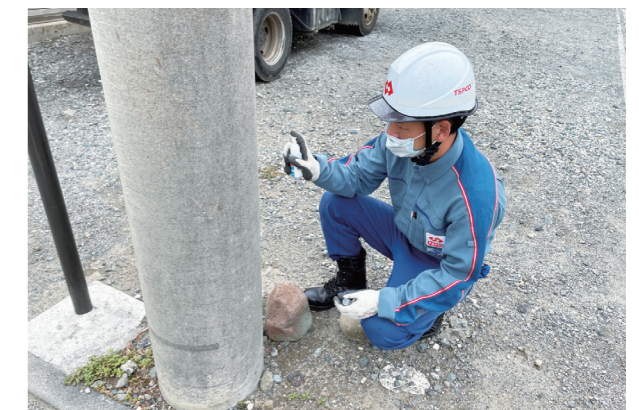
鉄筋コンクリート柱診断風景
