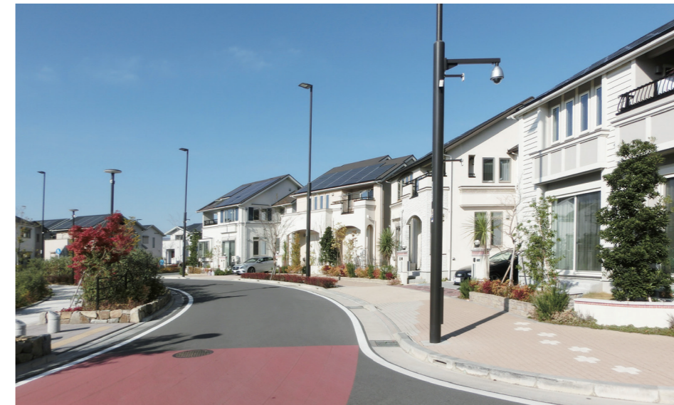
戸建地中化実績写真
