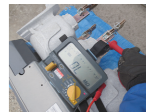
受変電VCB分解点検
