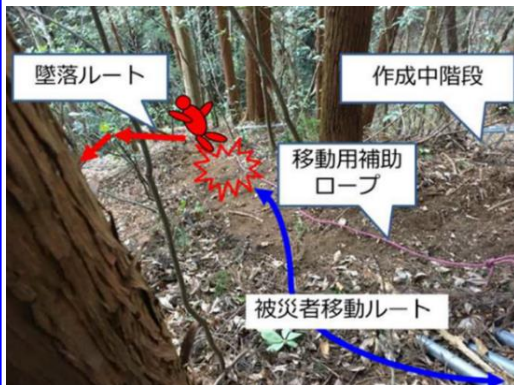
《巡視路整備業務にて斜面から墜落》
