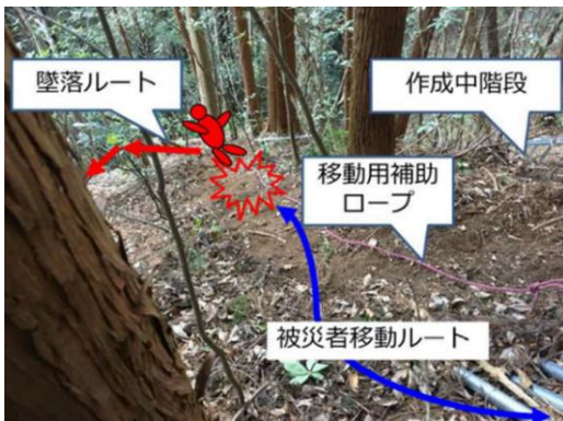
《巡視路整備業務にて斜面から墜落》
