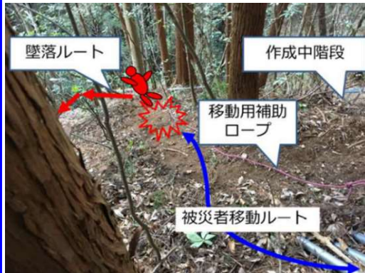
《巡視路整備業務にて斜面から墜落》
