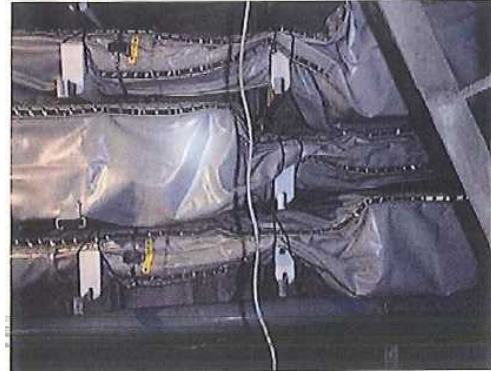
城北線 1 番防災対策状況
