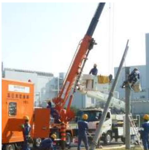
電力設備復旧
