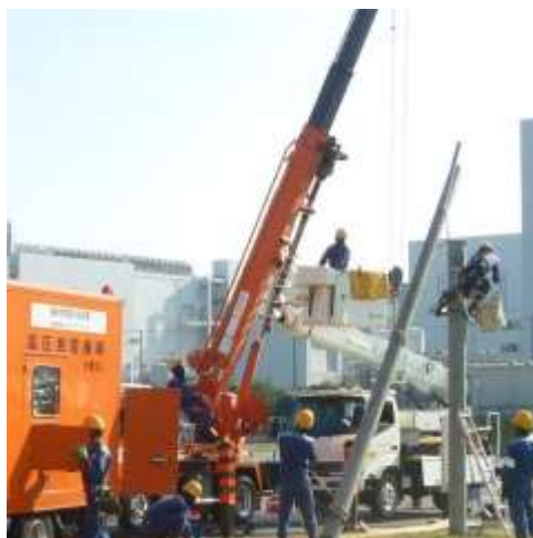
電力設備復旧
