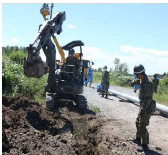
電柱建て込み場所の掘削作業
