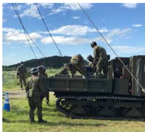
不整地運搬車による変圧器運搬
