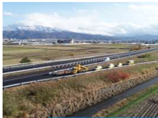
緊急開口部から高速道路への流入状況
