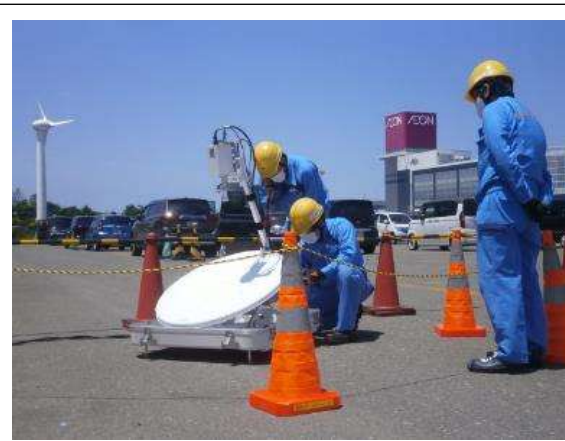
衛星回線を活用した通信回線設置
