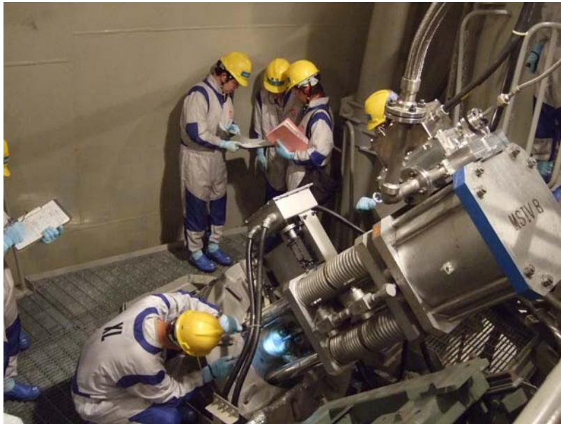
主蒸気隔離弁
