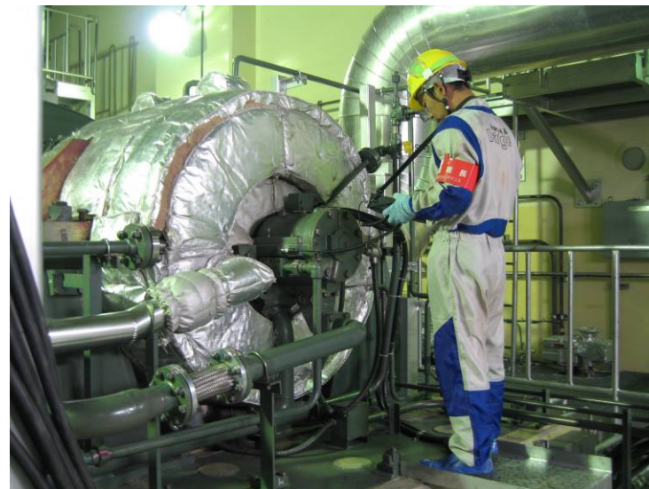
タービン駆動原子炉給水ポンプの振動診断
