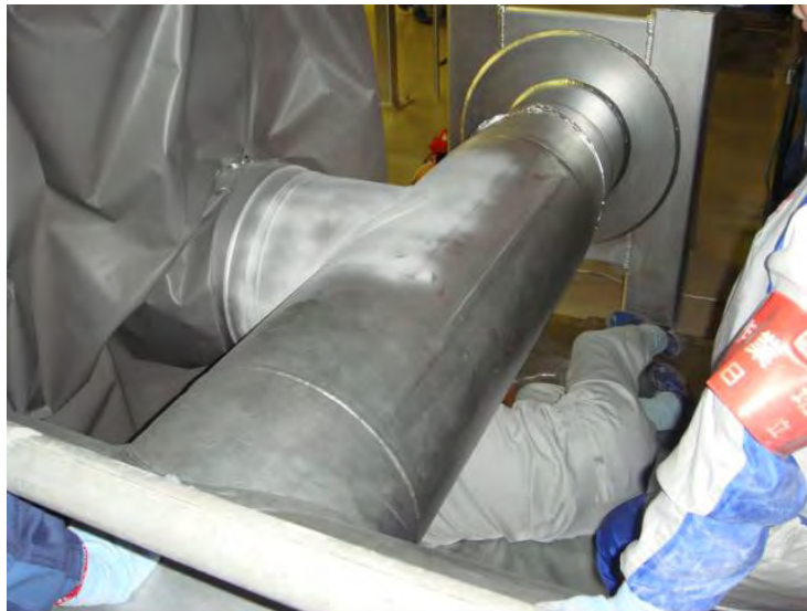
図-4 浸透探傷試験の実施状況
