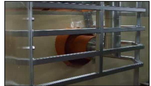
対策(柵の設置)
