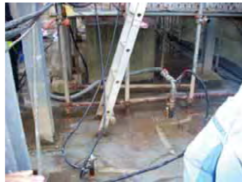
基礎に穴をあけ、モルタルを注入している
