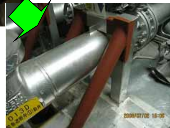
サポートを強固な構造へ変更した例
