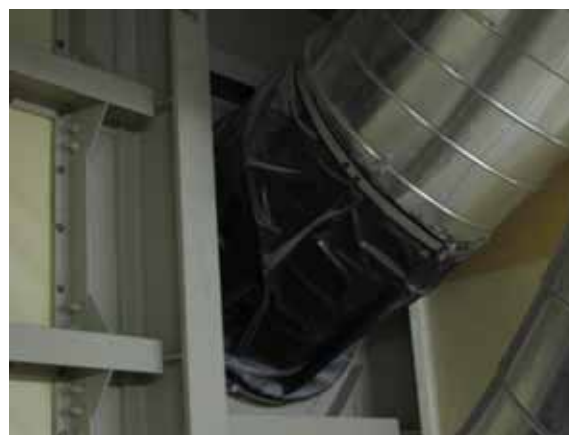
タービン建屋側貫通部
