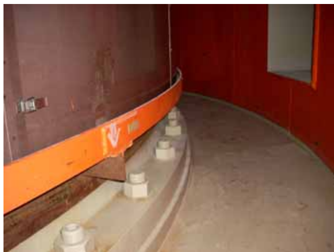
原子炉圧力容器基礎ボルト外観図
