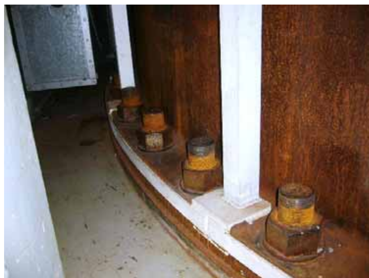
原子炉压力容器基礎ボルト外観図
