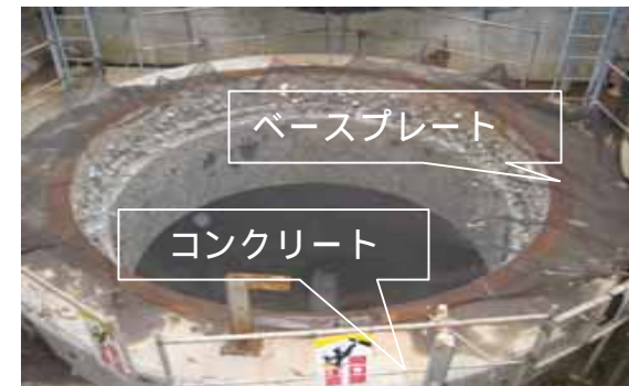
A号機：ポンプベース上面写真（1）
