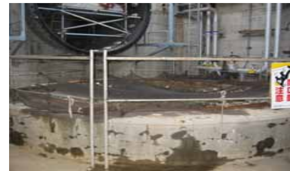
A号機：ポンプベース上面写真（2）
