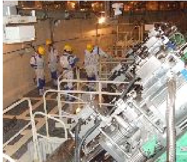
主蒸気隔離弁
