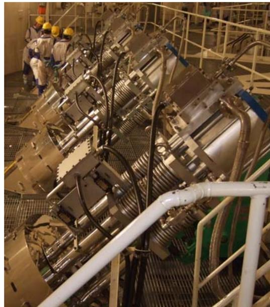
主蒸気隔離弁
