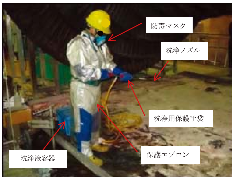
油圧式昇降装置下でのロータ下部の洗浄作業風景
