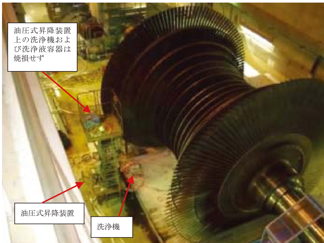
作業エリアの状況（タービン建屋1階 低圧タービン（A）ロータ）
