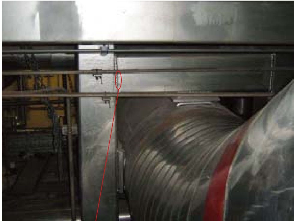
ひび割れ位置
