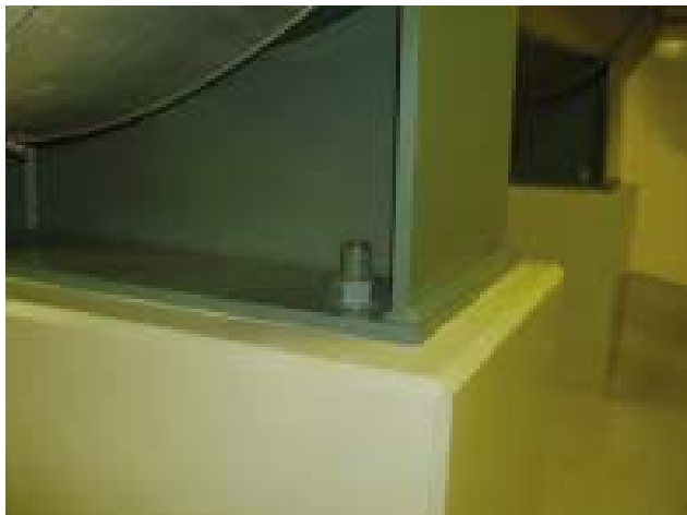
図一4 残留熱除去系熱交換器の目視点検状況（参考）
