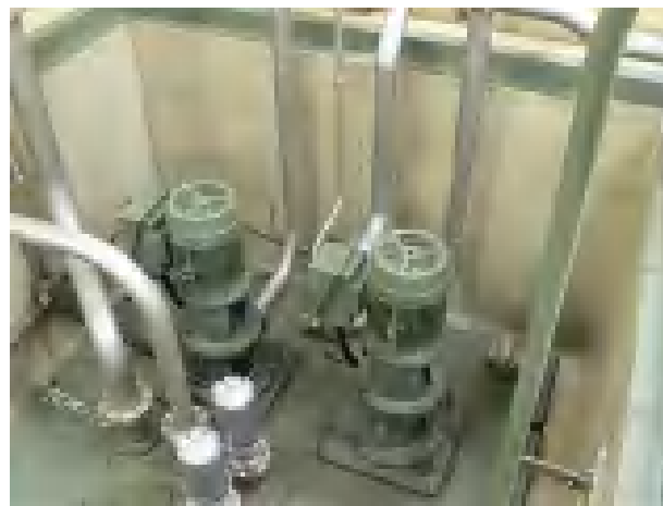
類似の電動機のサンプ内設置状況 （例：ストームドレンサンプ（ B ）内の電動機）
