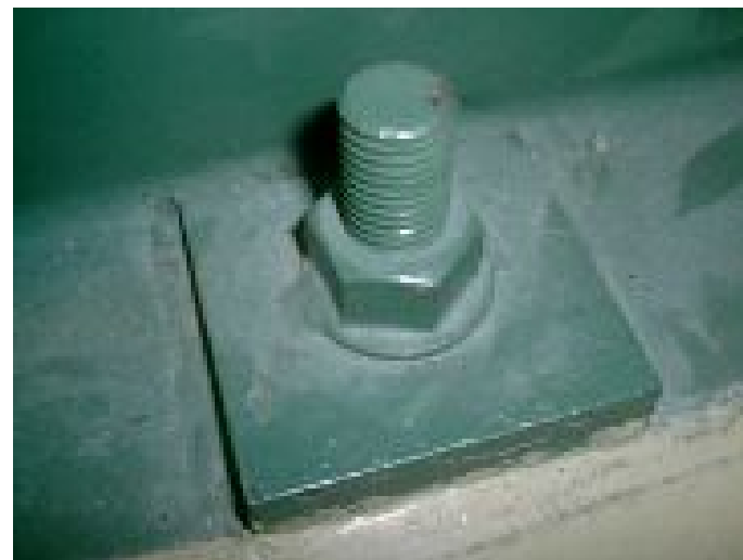
ほう酸水注入 ( A )基礎ボルト目視点検
