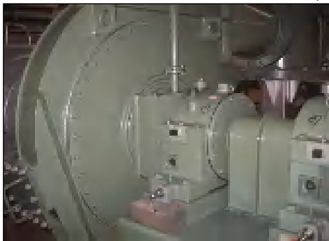
排風機(A)目視点検
