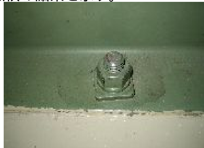
排風機(A)基礎ボルト目視点検
