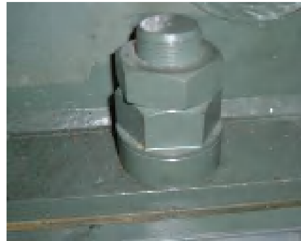
非常用ディーゼル機関(A)基礎ボルト目視点検
