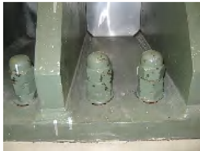
残留熱除去系熱交換器 ( A)基礎ボルト外観
