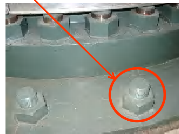
残留熱除去系ポンプ(A) 基礎部外観
