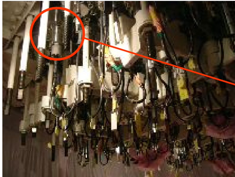
制御棒駆動機構外観
