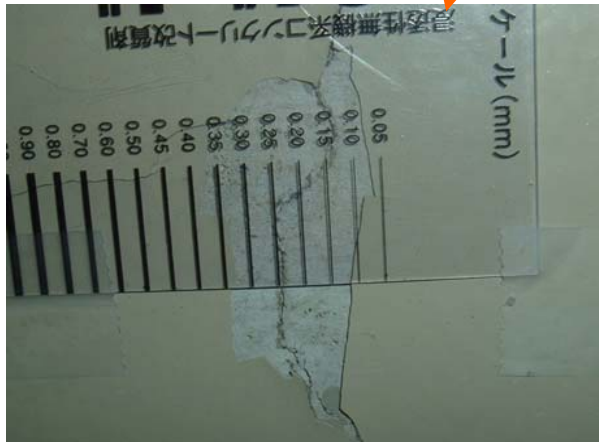
南側側面ひび割れ状況
