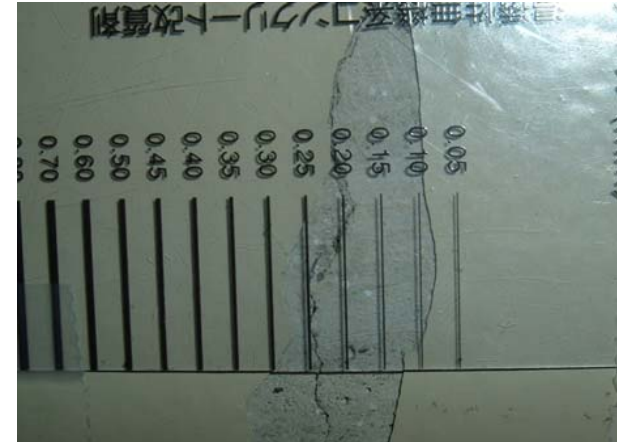
北側側面ひび割れ状況
