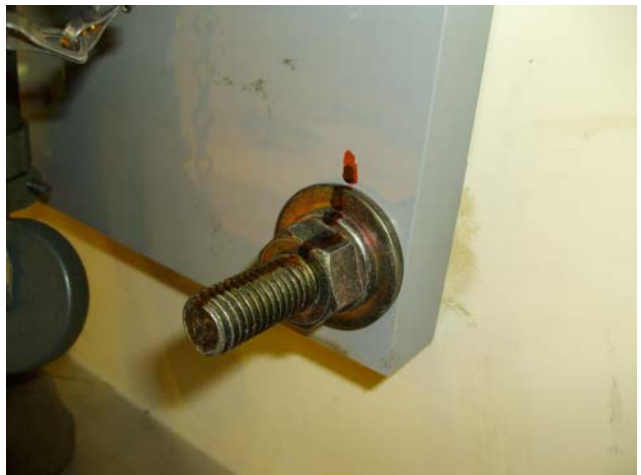
図一6 燃料取替エリア排気放射線モニタ（A）の目視点検状況（参考）
