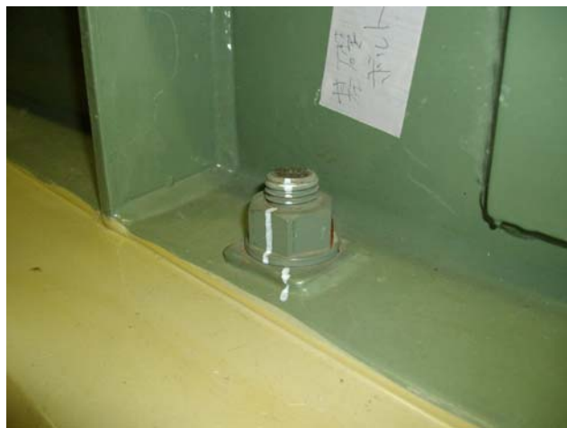
図一5 非常用ガス処理系フィルタ装置の目視点検状況（参考）
