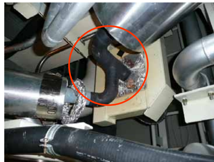
分岐管継手部 目視点検状況
