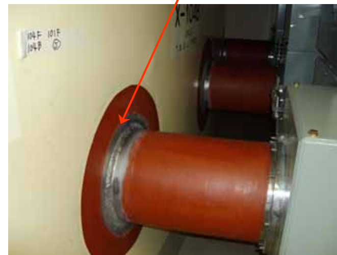
浸透探傷試験状況
