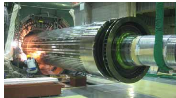
回転子の引き抜き外観図
