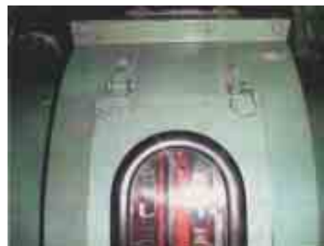
ディーゼル発電機（A）ブラシカバー用ホルダー損傷
