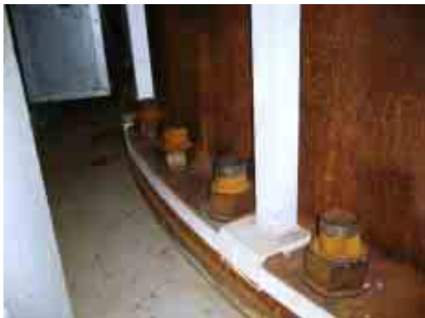
原子炉压力容器基礎ボルト外観図
