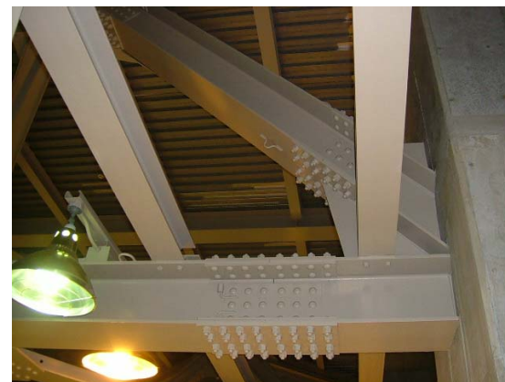
ボルト接合部
