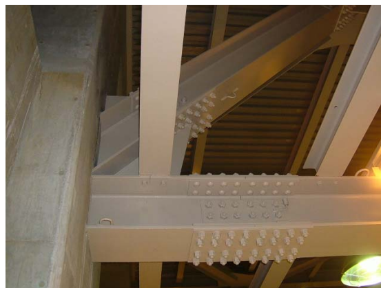
ボルト接合部
