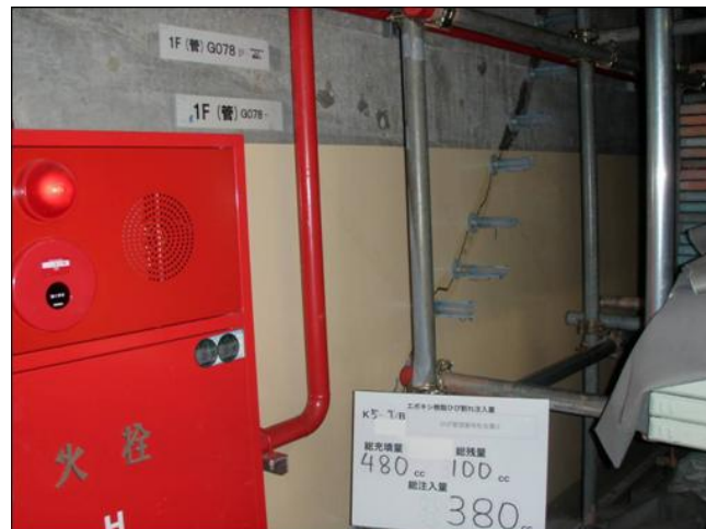
エポキシ樹脂注入
