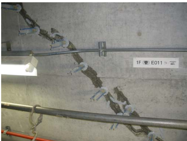
エポキシ樹脂注入
