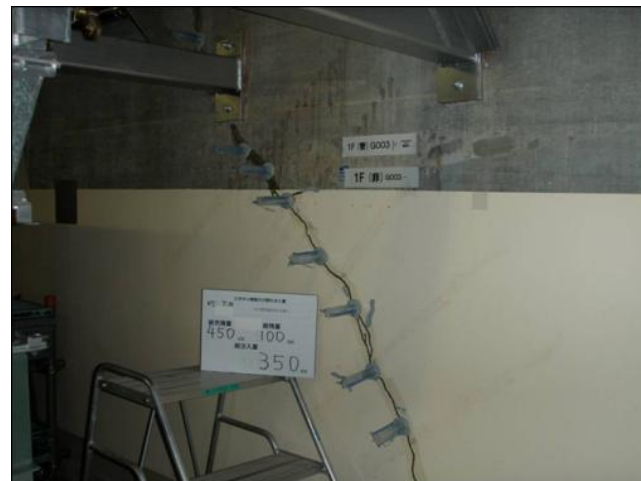
エポキシ樹脂注入
