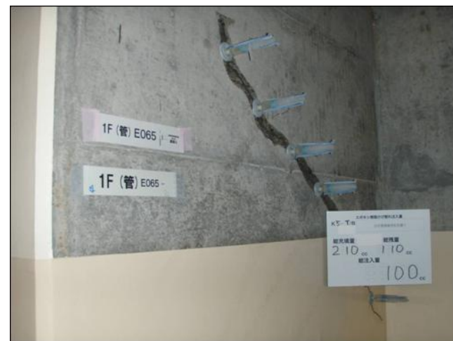
エポキシ樹脂注入
