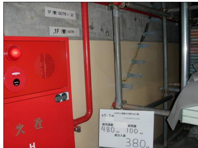
エポキシ樹脂注入
