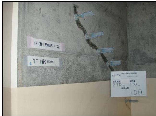
エポキシ樹脂注入
