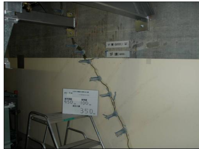
エポキシ樹脂注入
