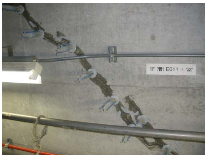
エポキシ樹脂注入
