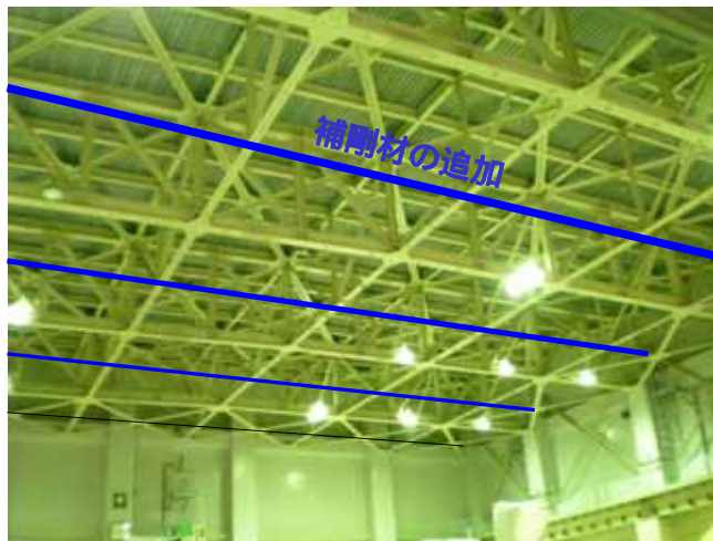
つなぎ梁下弦材への補剛材の追加
