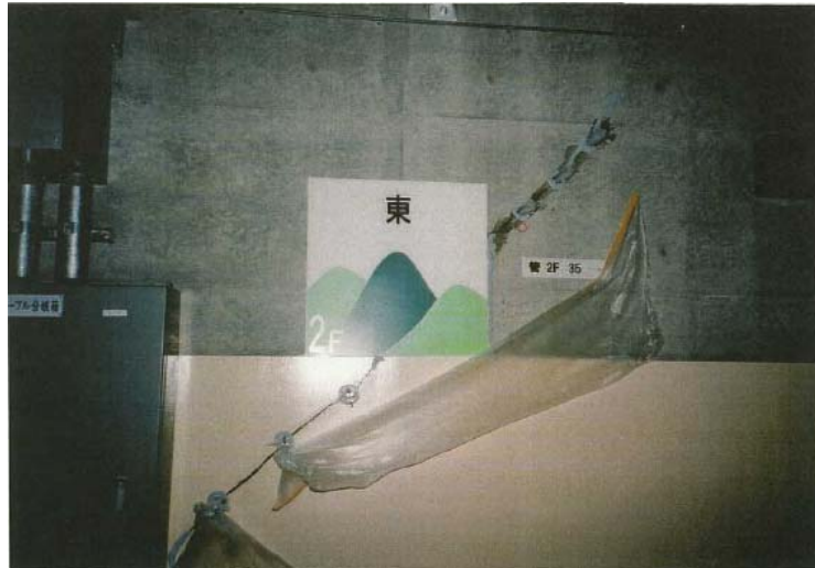
—補修実施状況（エポキシ樹脂注入状況）— （平成 18 年 3 月）
