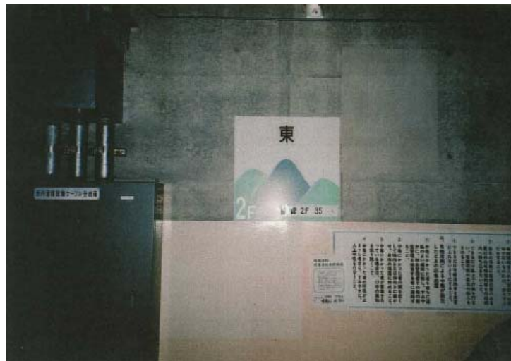
—補修完了状況— （平成 18 年 3 月）
